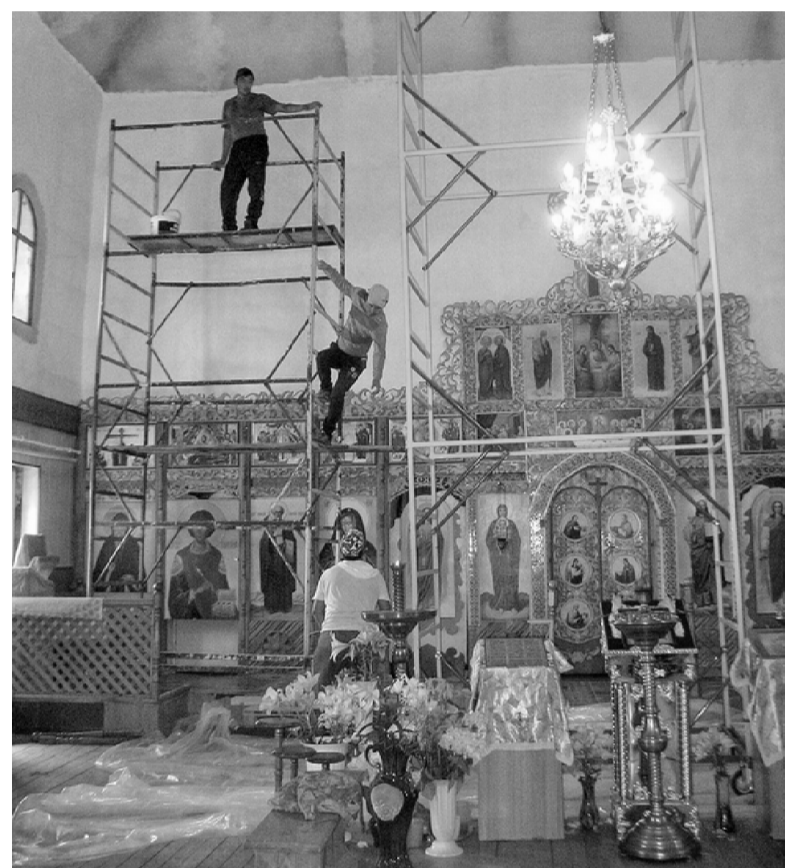
На снимке: ведутся ремонтные работы внутри храма.
